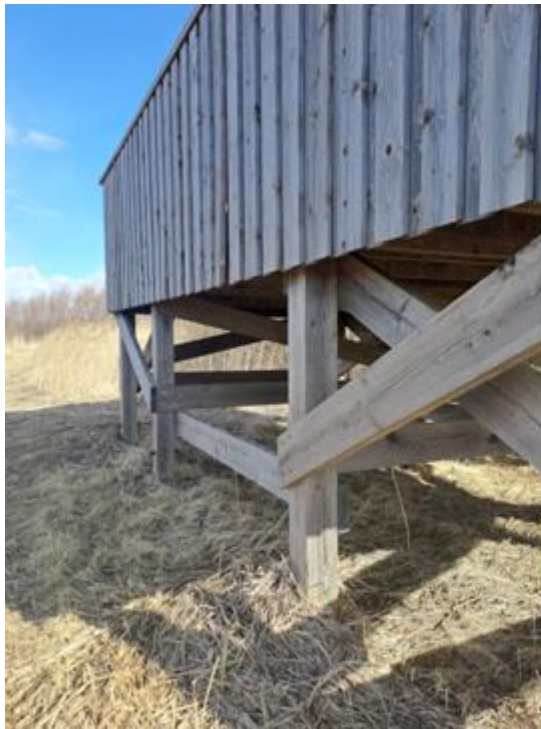
Kuva 109. Hyväkuntoiset tukirakenteet.
