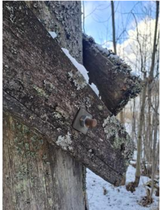
Kuva 14. Jäkälää rakenteissa.
