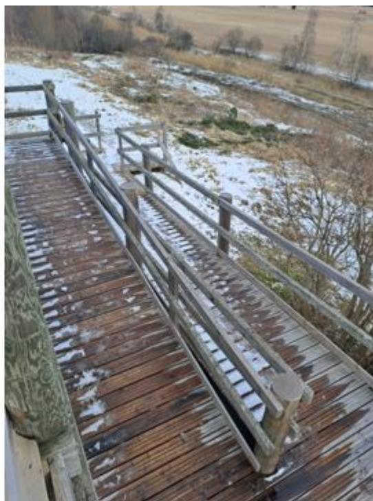
Kuva 25. Luontolavan ramppi ylhäältä päin.
