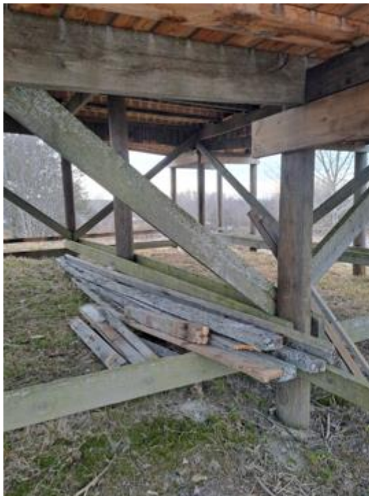
Kuva 30. Poistettuja materiaaleja lavan alla. Kuva 31. Lavan rikkinäinen tukipuu
