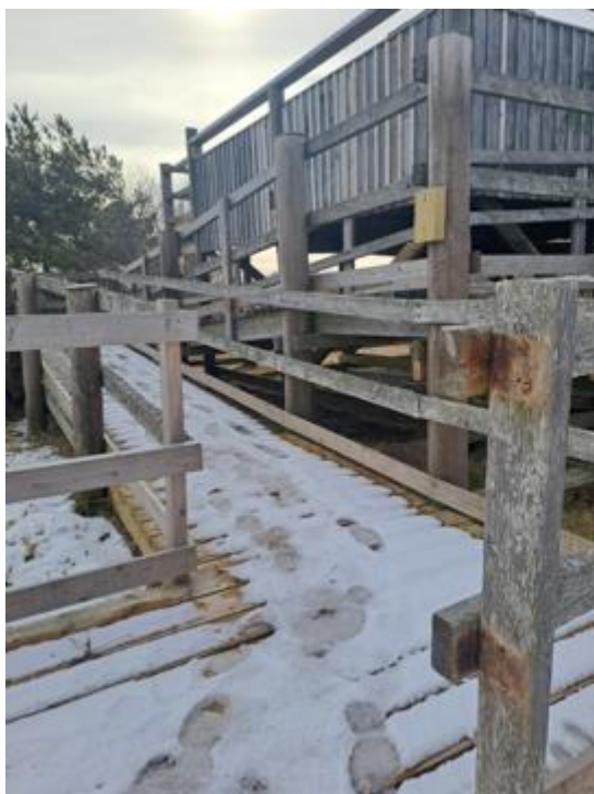
Kuva 24. Lavalle johtava pitkä ramppi.
