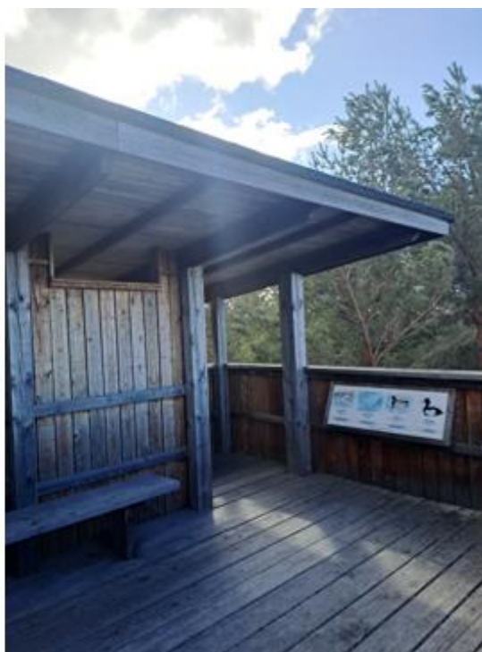
Kuva 80. Ylätasanteen osittainen katos.
