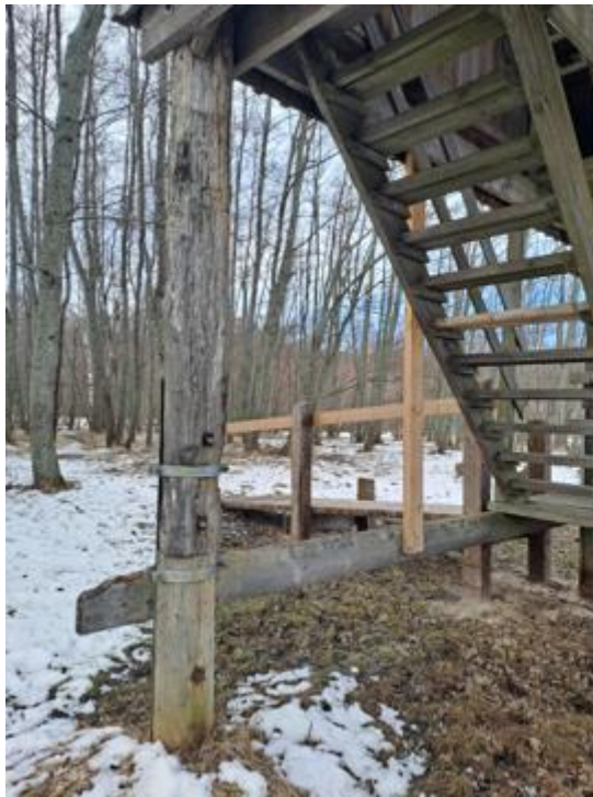
Kuva 54. Vahvistettu tukipylväs.
