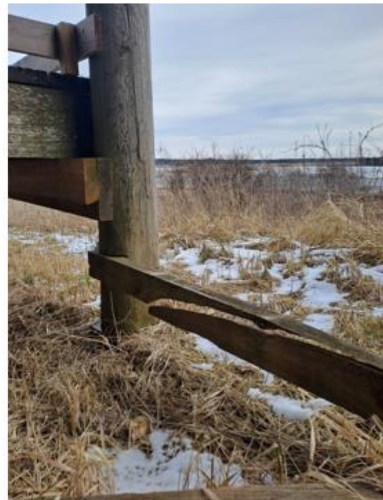
Kuva 30. Poistettuja materiaaleja lavan alla. Kuva 31. Lavan rikkinäinen tukipuu
