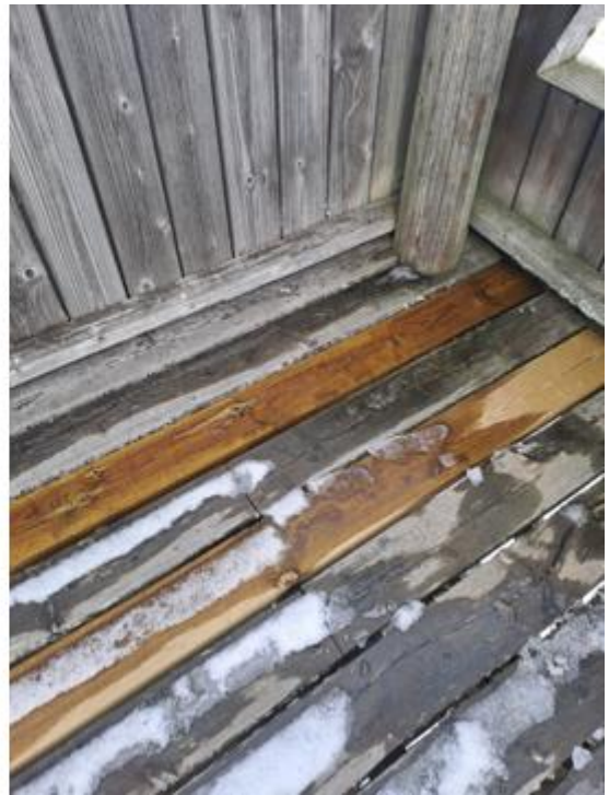
Kuva 51. Uusittua kansilaudoitusta.
