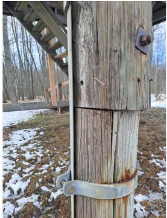
Kuva 55. Tukipylvään metallivanne.
