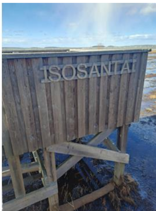
Kuva 100. Tornin tukipylväät.
